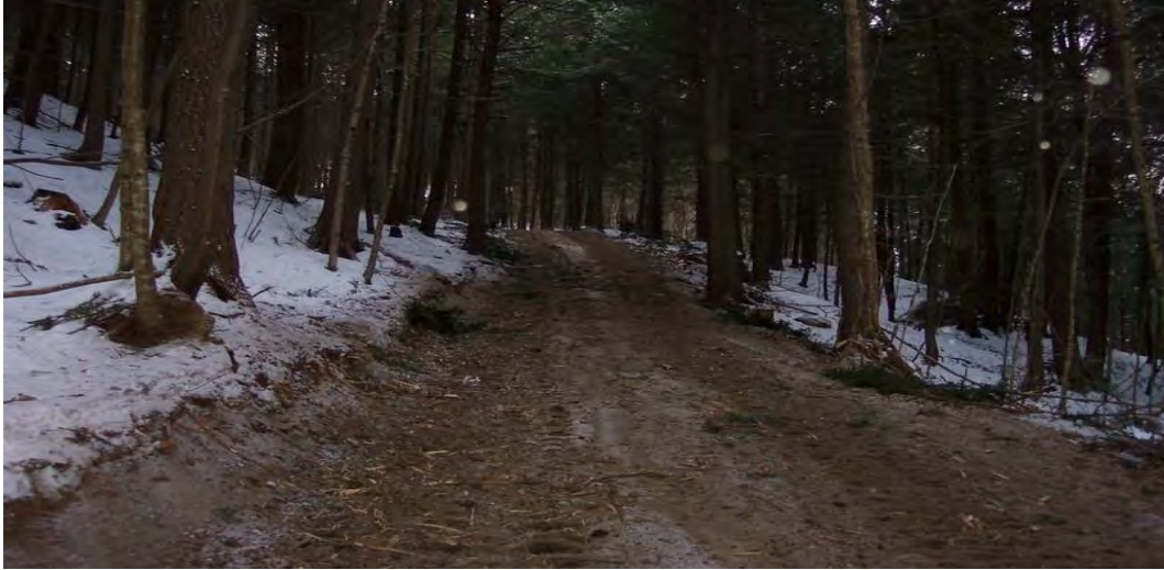
Şekil 2. Büyük miktarlarda kazı yapmadan oluşturulan traktör yolu örneği (URL-2).
