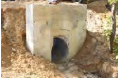
Şekil 1. Büz başduvarlarının hatalı yapılması ve büzlerin yanlış yerleştirilmesi
