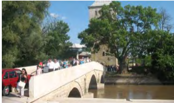
Şekil 4. Fatih (Bönce) Köprüsü ve Adalet Kasrı (Büyükyeğen, 2008)
