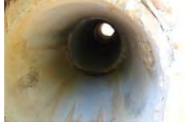
Şekil 1. Büz başduvarlarının hatalı yapılması ve büzlerin yanlış yerleştirilmesi
