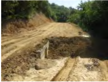
Şekil 3. Yol enkesitine göre küçük yapılan drenaj yapıları
