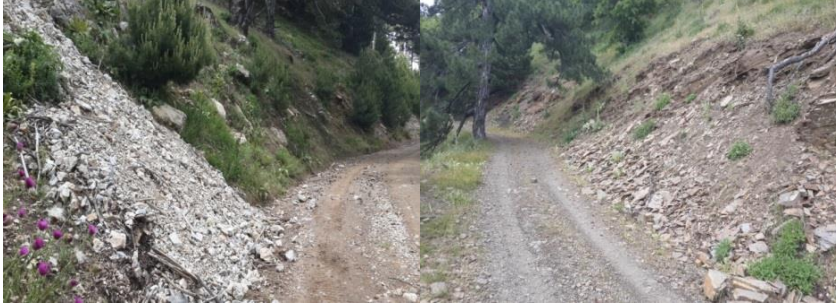
Şekil 21 ve 22. Meşcere içerisinde devrilme, yaralanmalar oluşması
