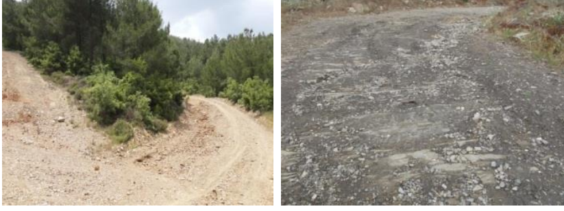
Şekil 17 ve 18. Heyelan oluşumuna, taş ve toprak akmasına etkisi
